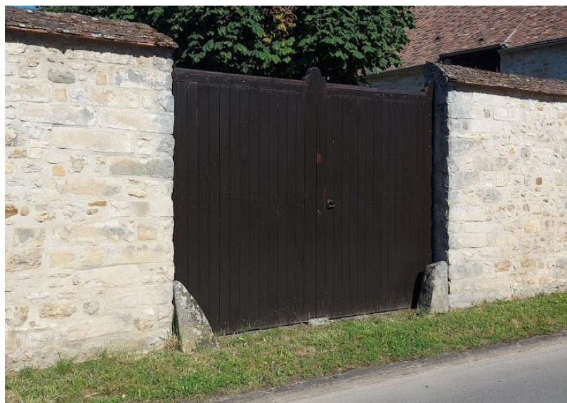
Les chasse-roues et les portes charretières
