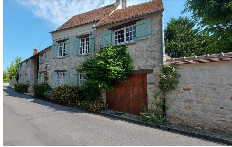
Pierres meulières et grès Enduit à pierre vue
