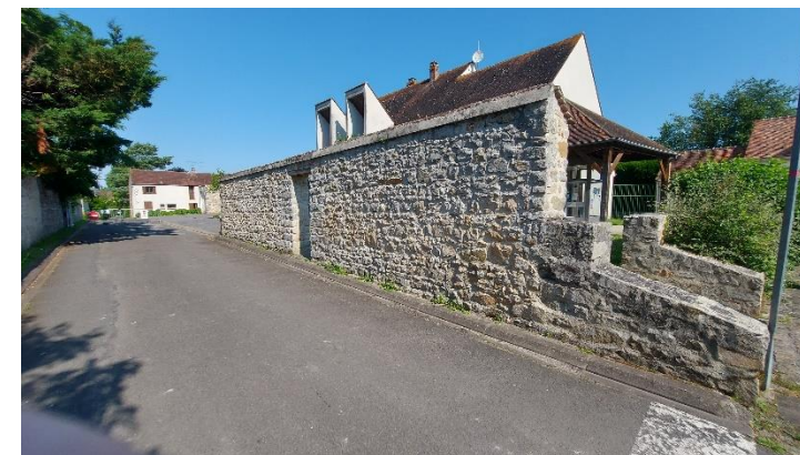
L'ancien mur devant la Poste
