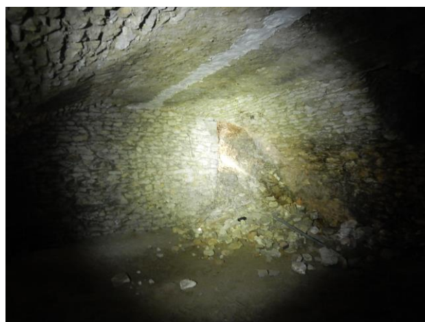
La cave en direction de l'entrée, cette dernière a été en partie obturée. Une saignée moderne a été pratiquée sur toute la longueur de la partie centrale de la voûte
