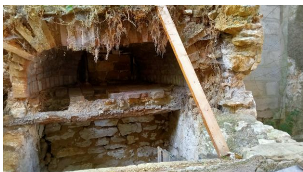
Vue de la partie du four située partiellement au-dessus de l'accès à la cave
