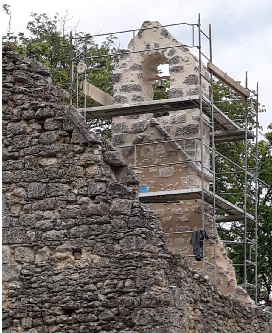
Le clocher de la chapelle de Fourches pendant les travaux de réfection des joints.
