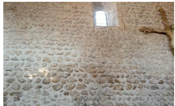
Mur intérieur nord de la nef de La Celle-sur-Seine
