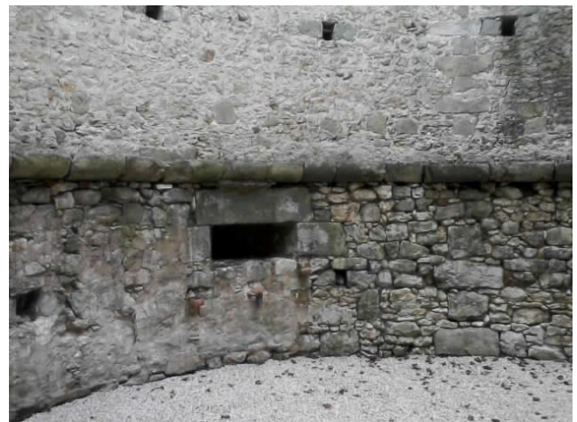
soubassement de la tour, couronné d'une corniche
