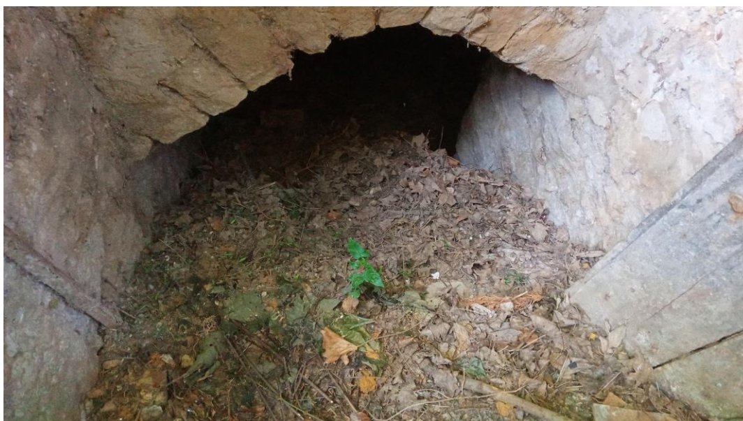
La voûte d'accès à la cave
