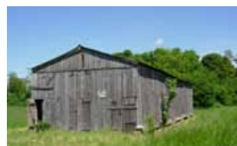
Ancien bâtiment agricole en bois
