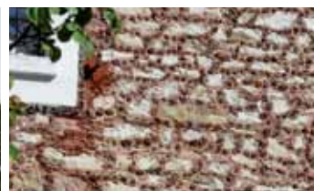
Ornementation en "rocaille" d'une façade en meulière
