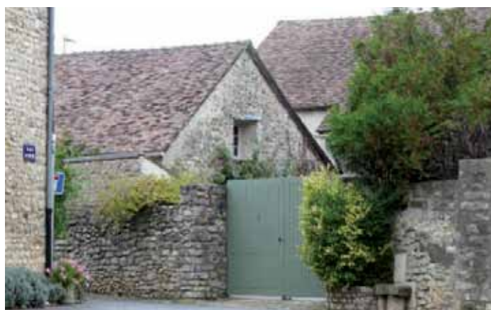
Les façades de pierres mélangées, principalement en grès ou en calcaire, sont caractéristiques du bâti traditionnel du Parc
